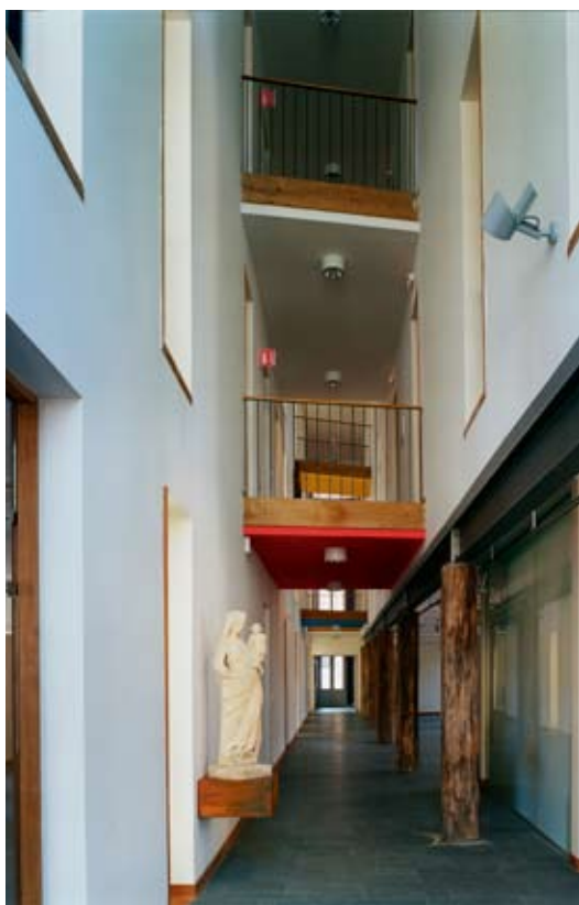
Maison diocésaine de Châlons-en-Champagne Les poteaux en bois sont des troncs d'arbres abattus par la tempête de 1999 et recyclés pour la cause. Architecte : Atelier Meandre, Paris © Luc Boegly
