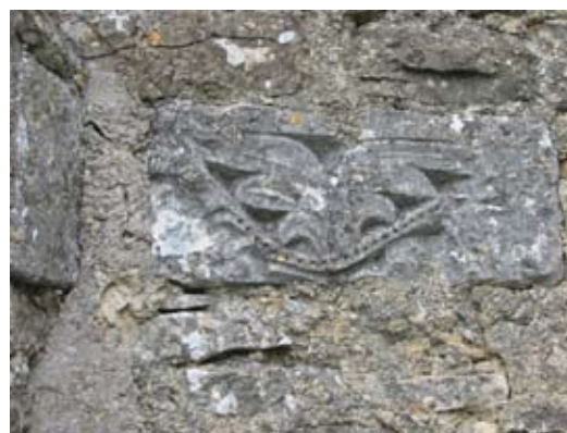
Pierre de rempli incluse dans un des murs de l'église de Battigny (Meurthe-et-Moselle, France) © Lorenzo Diez
